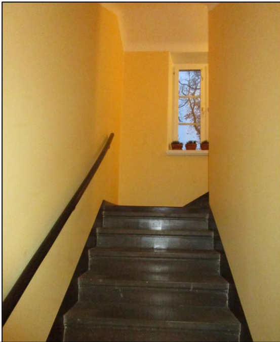
Trapphus med målade väggar och trappor av sten
