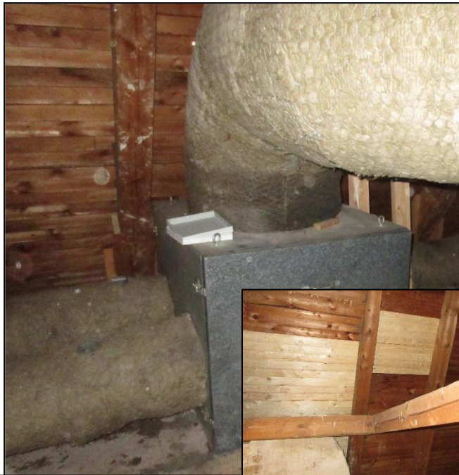
Ventilationsaggregat och utbytt råspont.
